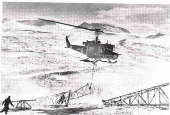
Vid våra kraftverksbyggen har försvarets hkp också gjort en god insats. Här får vågdonet sitt verkliga elddop.
